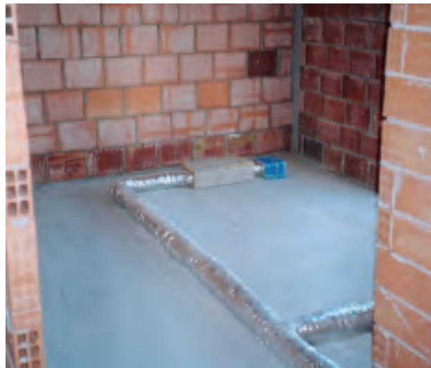
Condotte posate sulla soletta del primo piano (nella foto si distinguono i silenziatori).
