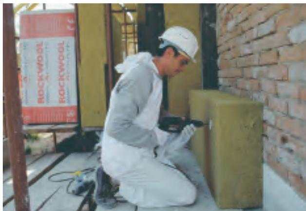
Posizionamento dello strato di isolante costituito da pannello Rockwool da 24 cm mediante fissaggio meccanico puntuale a mezzo di appositi tasselli.
