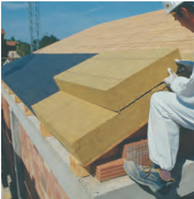
Isolamento della copertura: posa della barriera al vapore sul primo assito e doppio strato di pannelli isolanti in lana di roccia sp. 15 + 15 cm
