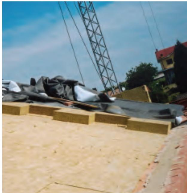
Dettaglio della stesura del secondo strato di pannelli isolanti in lana di roccia 15 cm e della barriera acqua-vento.
